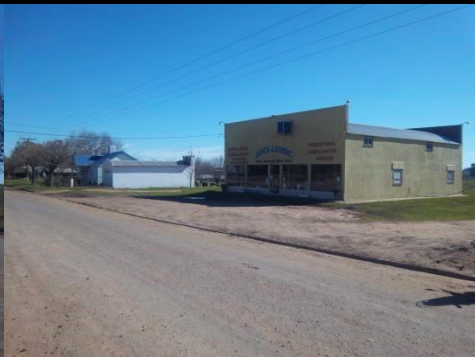
Construcción al sur-oeste.
