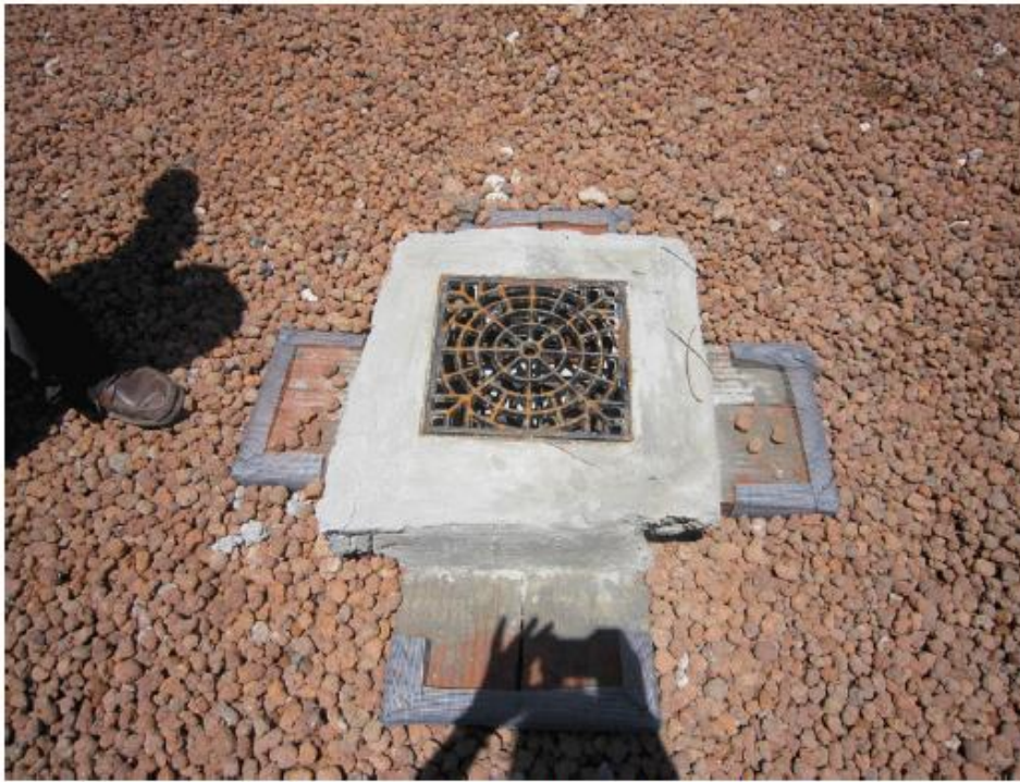
Terminación con leca en sector de rejilla de desagüe
