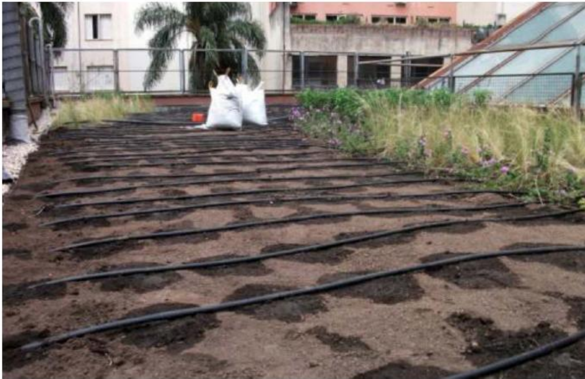
Sistema de riego por goteo
